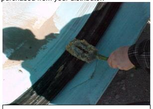
Photo 8 (lubricate gasket)
